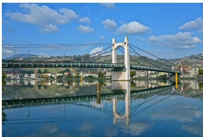
**Le pont de Condrieu-Les Roches est placé depuis 2013 sous haute surveillance, du fait de la dégradation de ses câbles de suspension.**
