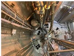
Opération de vidange du bloc pile et de séchage avant de passer en eau légère
